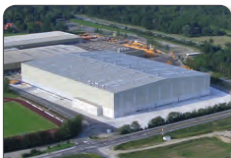
Inauguración de la nave de montaje de máquinas para manipulación de material
